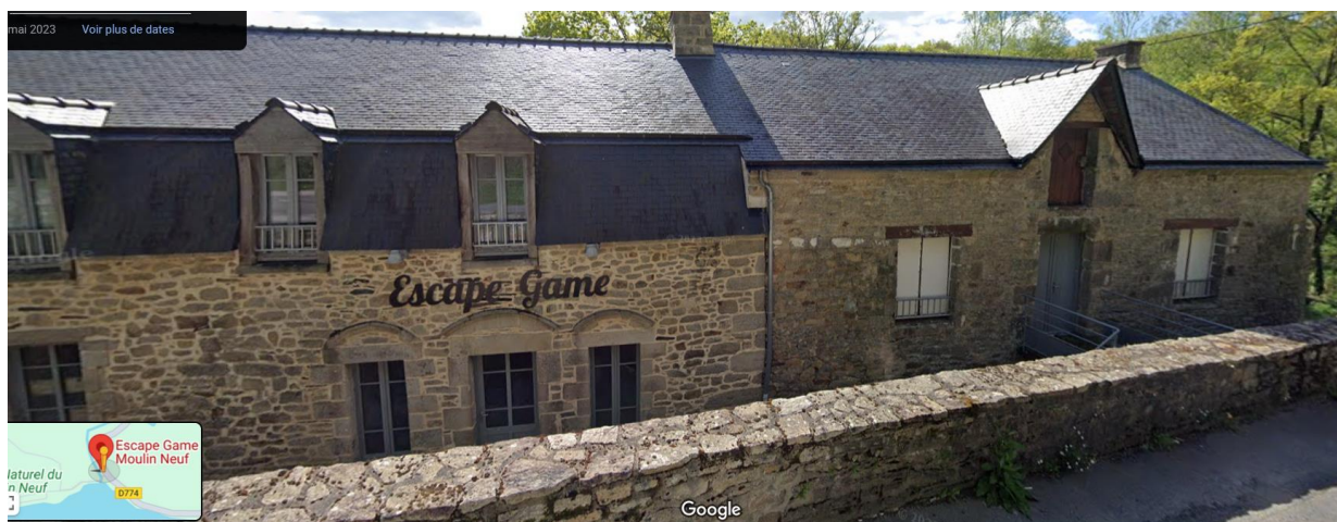
Photo 13: a gauche, la partie rénovée, à droite : la partie non rénovée – source google map
