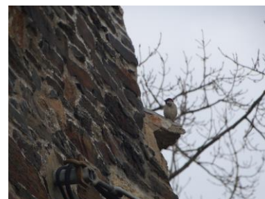
Habitats sur la zone d'étude – élément bâti abandonné.
