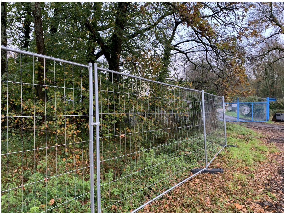
Figure 8 : Illustration de mise en défens en phase chantier
